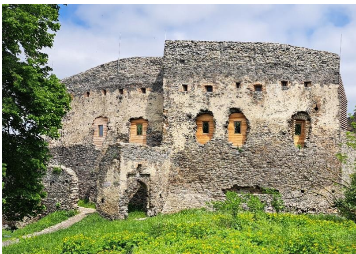
8. kép A vár DNY-i homlokzata a helyreállítást követően
