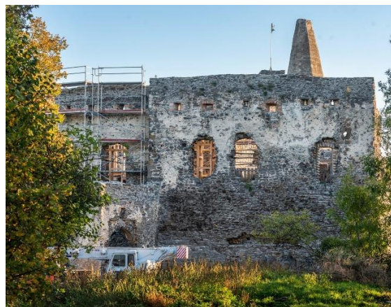
11. kép A Vár DNY-i homlokzata a felújítás közben
