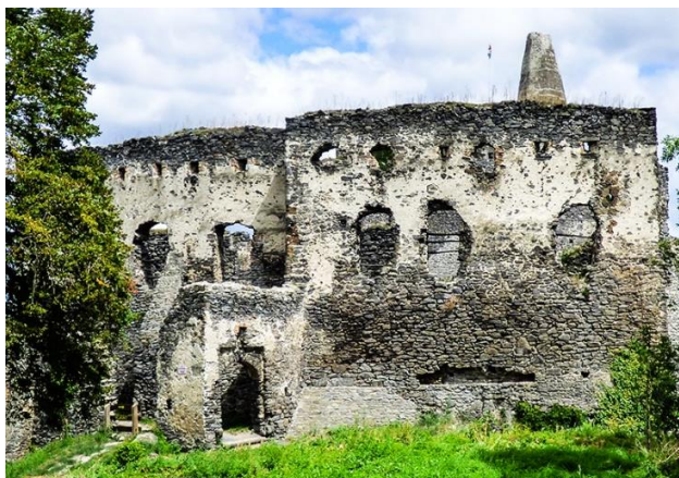
10. kép A DNY-i homlokzat a felújítás előtt
