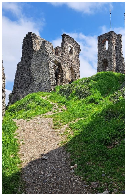
9. kép A keleti palotaszárny
